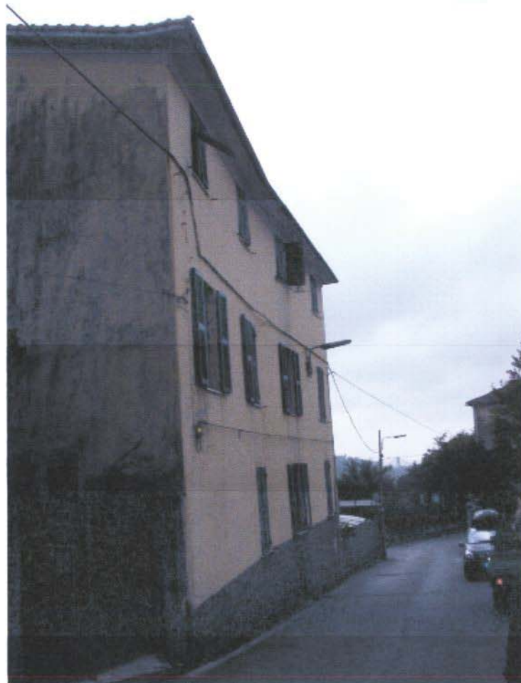
Foto 13: vista del fabbricato ad uso residenziale
